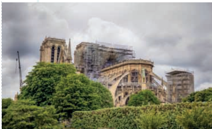
▲ Notre-Dame de Paris, travaux de renfort en cours après le feu, pour empêcher la cathédrale de s'effondrer
